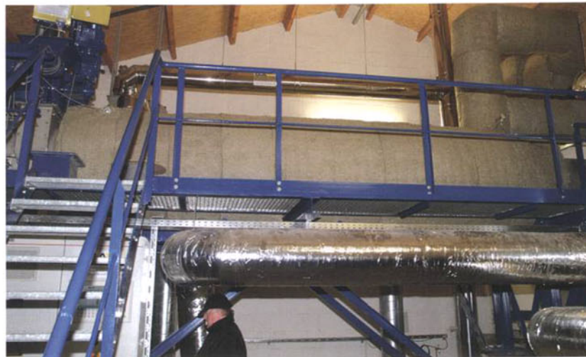
Im Pyrolysereaktor wird das Holz bei ca. 550 Grad verschwelt.
